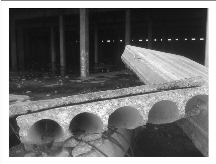
*Estado del depósito de agua de Melilla cuya rotura provocó la riada de sus 20.000 m<sup>3</sup>. Pueden apreciarse los bloques que formaban la pared que cedió y que se desplazaron sobre las aguas destrozando todo lo que se interponía en su camino.*
